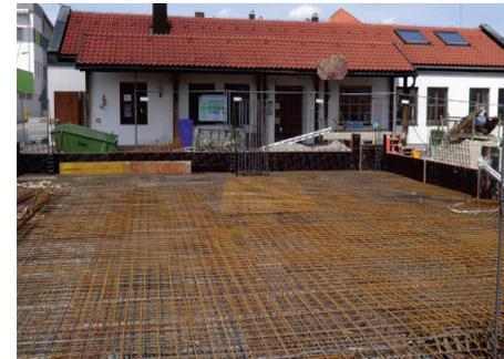
Sauberkeitsschicht aus Beton. Auf dieser Grundbasis wurden dann ca. 10 Tonnen Armierungsstahl und Baustahlmatten eingebaut und mit ca. 95 m<sup>3</sup> Beton zu einer 35 cm dicken Bodenplatte vergossen.
